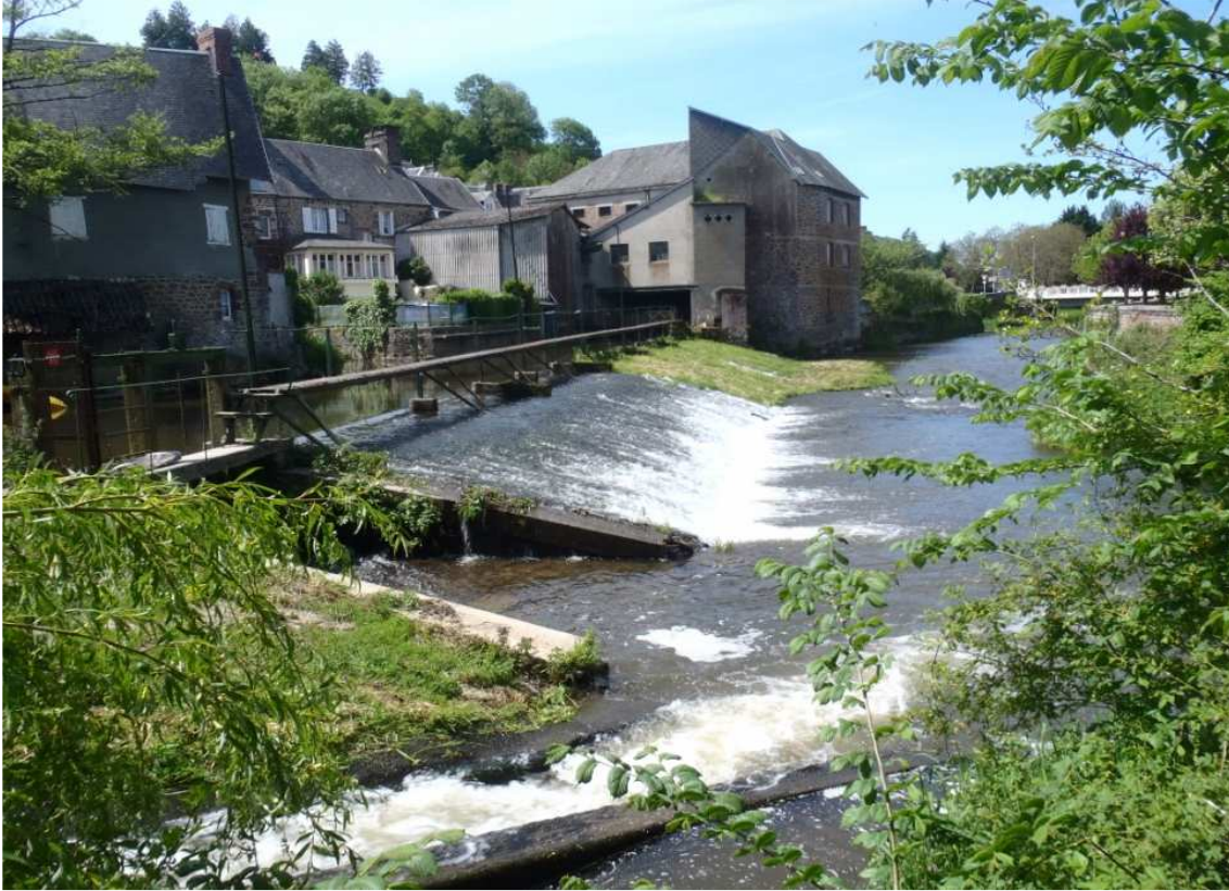
Photo du barrage du moulin de Gavray (Crédit : SIAES)
